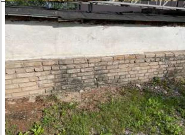
**Фото 98.** Отсутствие отмостки здания.
