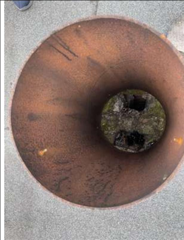
**Фото 34.** Вентиляционная шахта. Отсутствие окрытия шахты.
