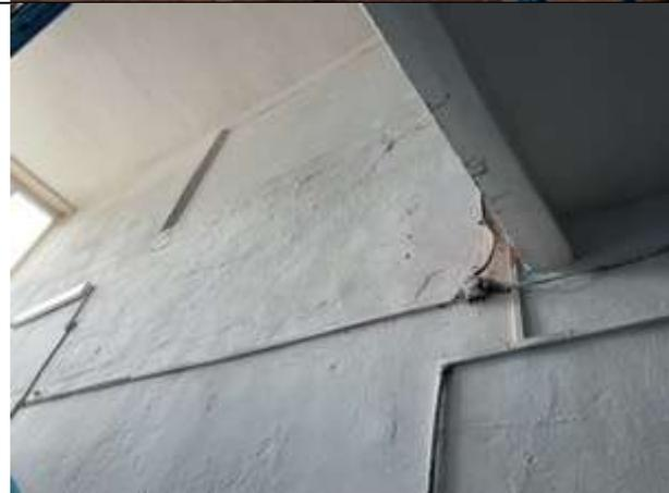
**Фото 129.** лестница №2. Отслаивание штукатурного и покрасочного слоя от стен здания.
