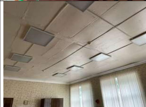
**Фото 60.** Устройство потолков из плитных древесно-плитных материалов. Стены оклеены обоями.
