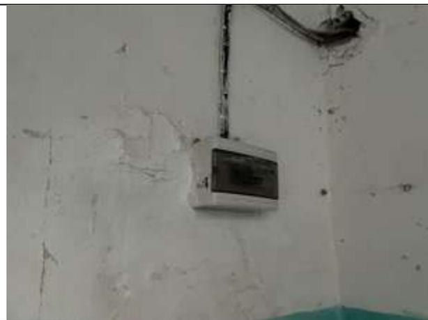
**Фото 112.** лестница №4. Отслоение штукатурного и покрасочного слоя стен здания.
