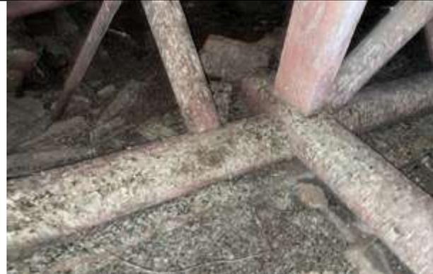
**Фото 67.** Помет на стропильной системы и чердачном перекрытии толщиной до 10 мм.
