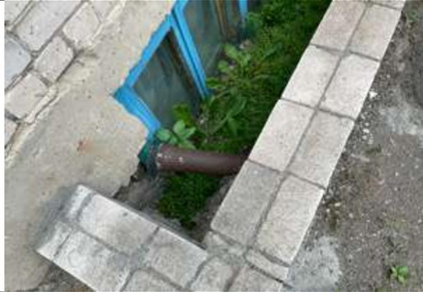
**Фото 13.** Отсутствие водостока из приемки. Уровень земли в приемке выше уровня окна. В приемке проходит канализационная труба.
