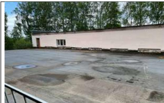
**Фото 95.** Вид кровли и дворового фасада спортзала. Отсутствие нормативной разуклонки.
