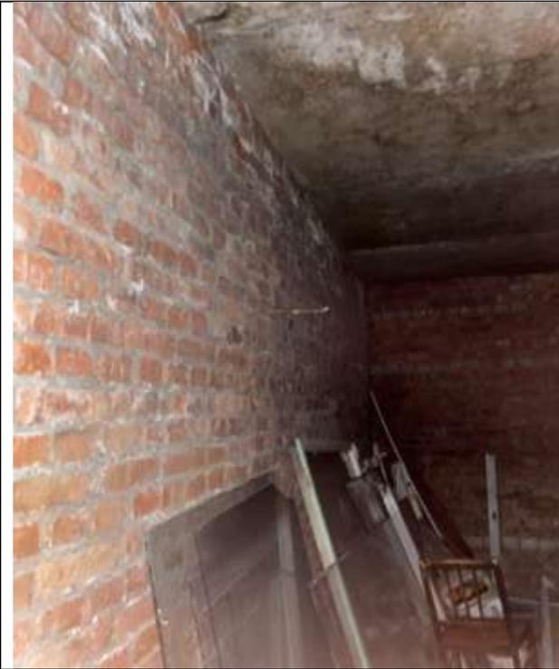
**Фото 81.** Примыкание корпуса А3 к корпусу А2. Следы намокания ж/б плиты перекрытия.
