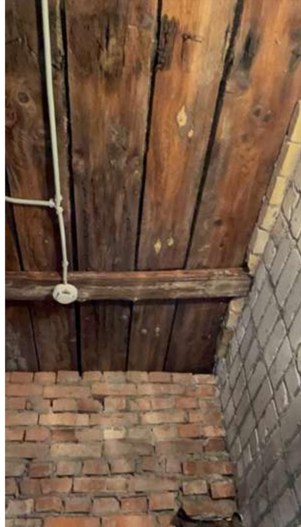
**Фото 80.** Примыкание корпуса А к корпусу А2. Следы намокания деревянных конструкций.
