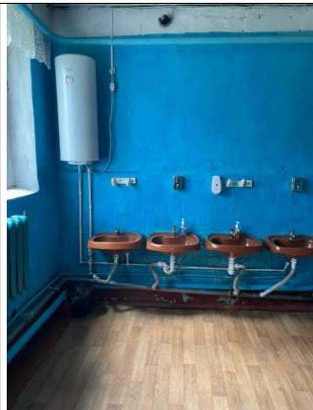
**Фото 85.** Устройство отопления и водоснабжения из полипропиленовых труб. Отслаивание штукатурного слоя поверхности стен.
