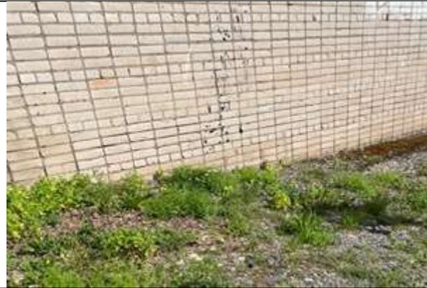
**Фото 99.** Отсутствие отмостки здания.
