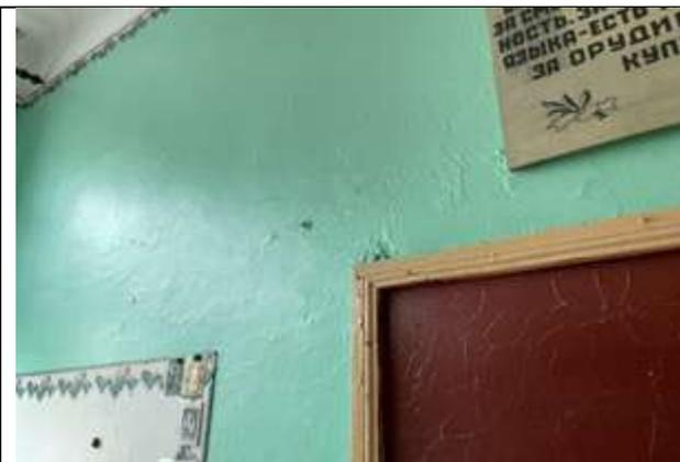
**Фото 57.** Отслоение штукатурного слоя поверхности стен.
