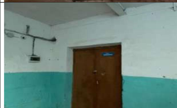
**Фото 111.** лестница №4. Отслоение штукатурного и покрасочного слоя стен здания.
