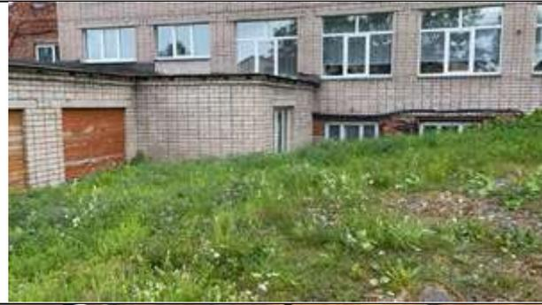
**Фото 79.** Общий вид здания. Отсутствие отмостки.
