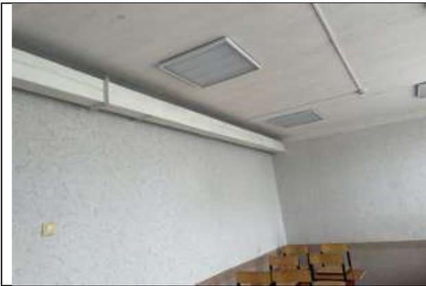
**Фото 29.** Следы намокания на потолке.
