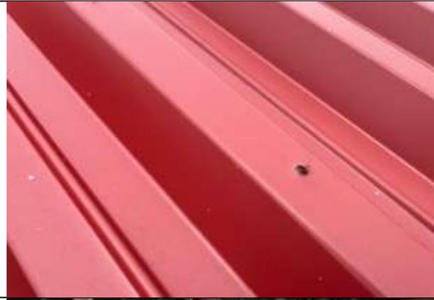
**Фото 65.** Отверстие в покрытие кровли.
