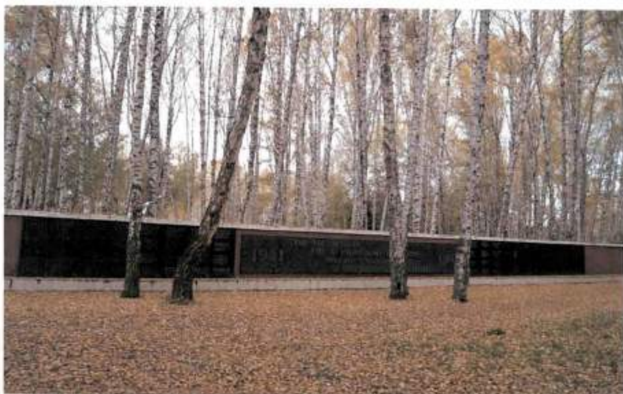
Фото 9. Фрагмент ограждающей стены с внешней стороны
