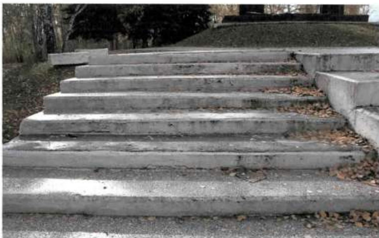
Фото 4. Фрагмент бокового лестничного марша с северной стороны
