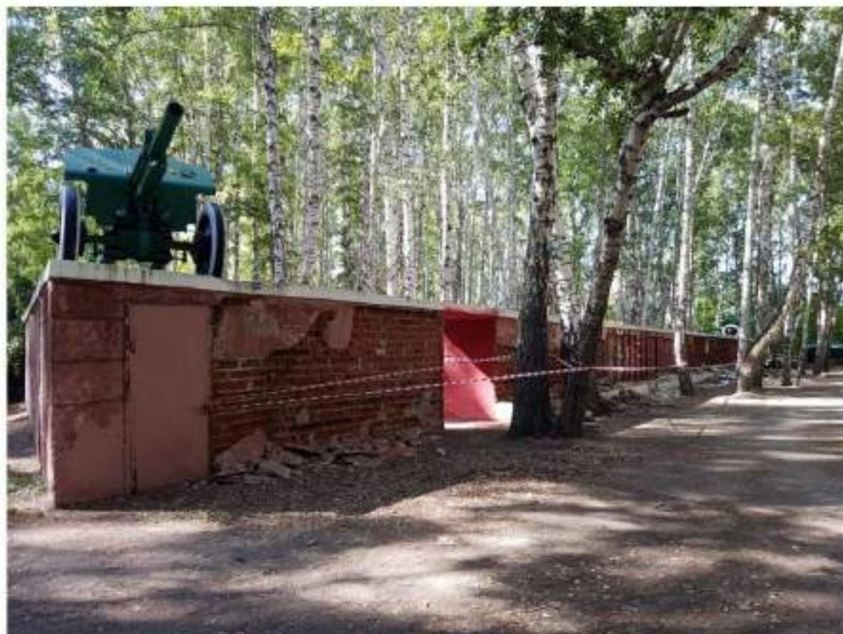
Фото 3. Вид на восточную стену с юго-востока
