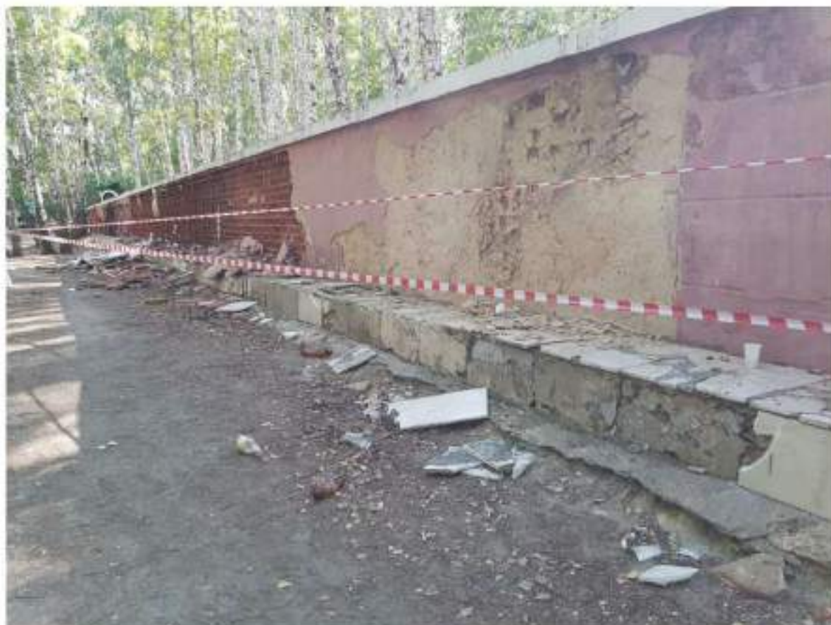
Фото 1. Вид на наружную сторону восточной стены с северо-востока при расчистке от бухтящей штукатурке
