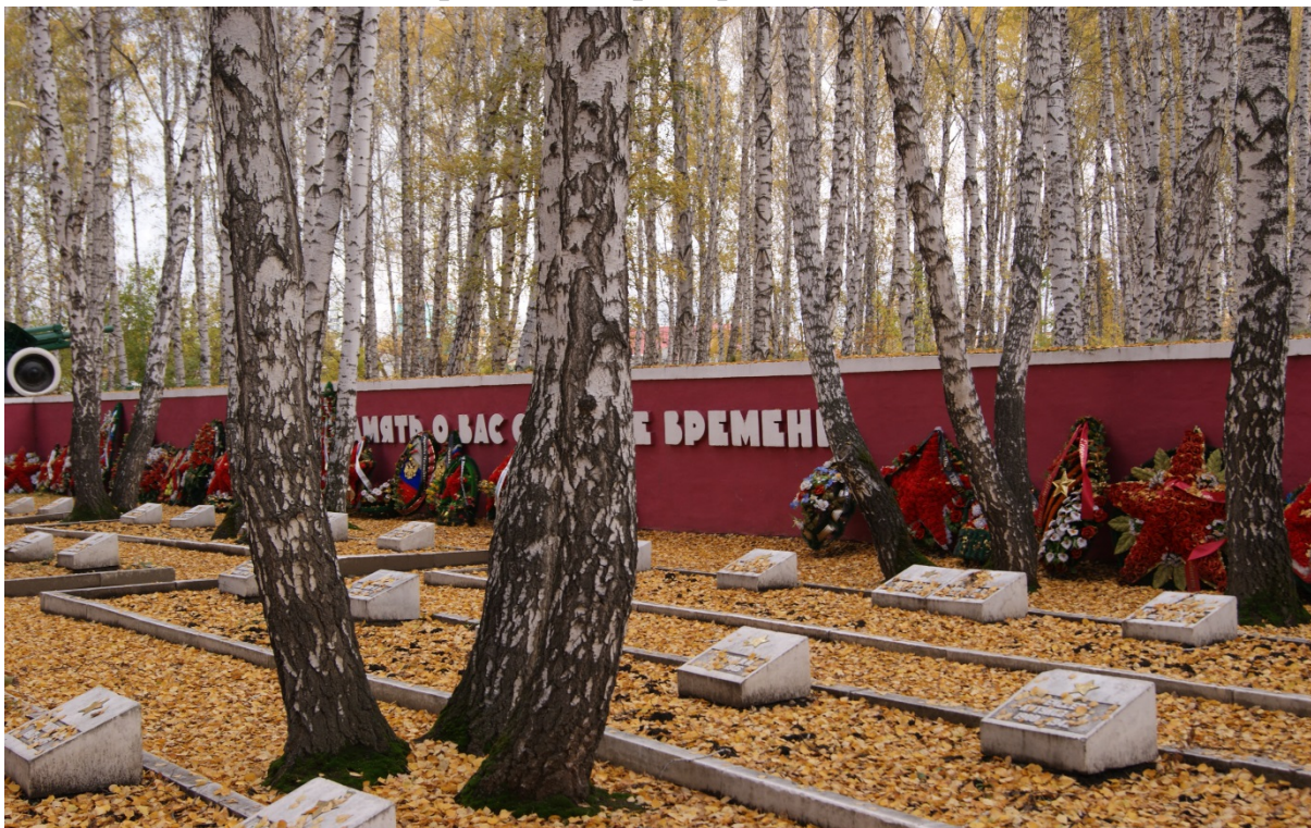
Фото 8. Фрагмент ограждающей стены с внутренней стороны
