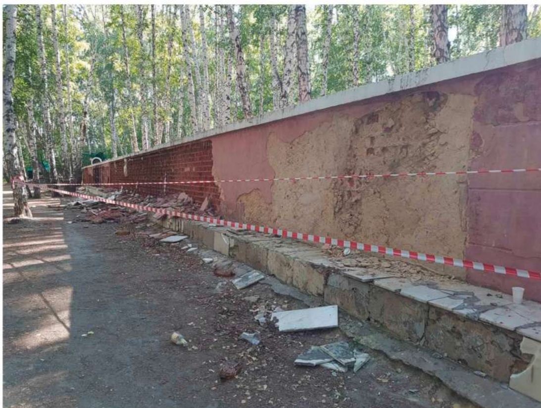
Фото 47. Вид на наружную сторону восточной стены с северо-востока при расчистке от бухтящей штукатурки (июнь 2020 г.)
