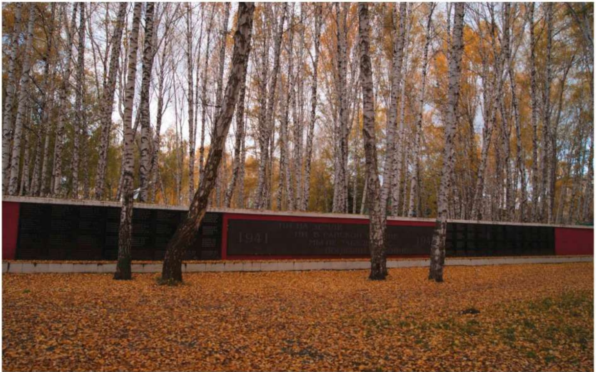
Фото 35. Фрагмент ограждающей стены с внешней стороны
