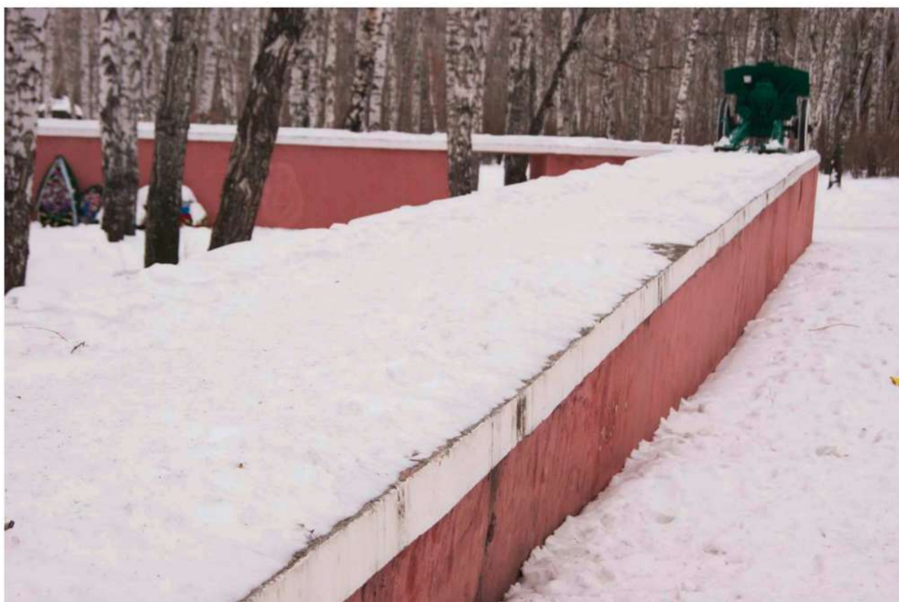
Фото 44. Фрагмент ограждающей стены. Вид с юго-запада
