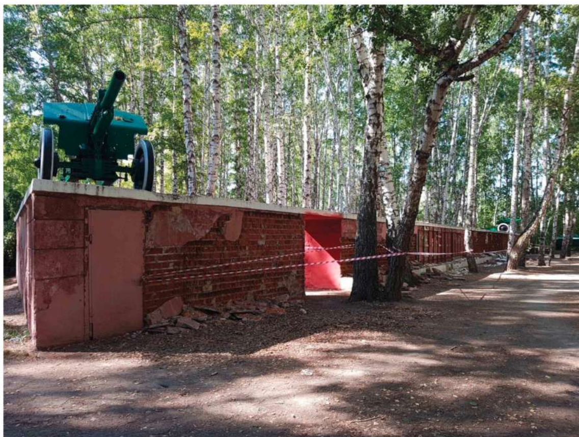
Фото 48. Вид на наружную сторону восточной стены с юго-востока при расчистке от бухтящей штукатурки
