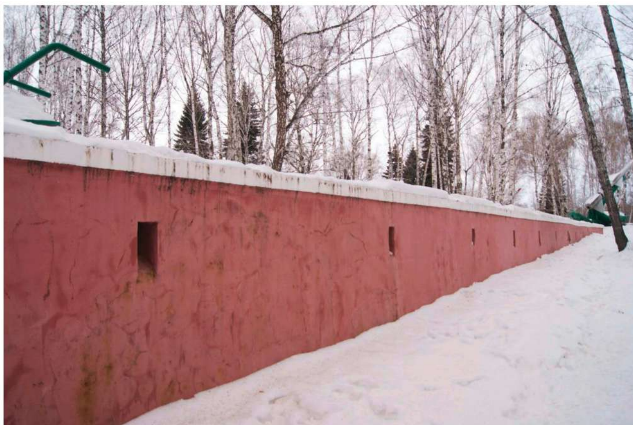
Фото 46. Фрагмент внутренней ограждающей стены. Вид с юго-востока Вид с северо-востока
