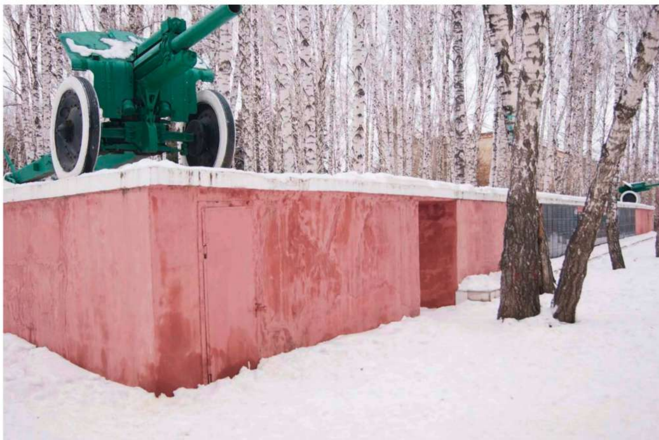
Фото 45. Фрагмент внешней ограждающей стены. Вид с юго-востока
