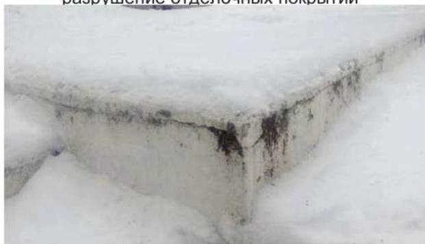
Фото 1. Трещины в облицовочном слое
