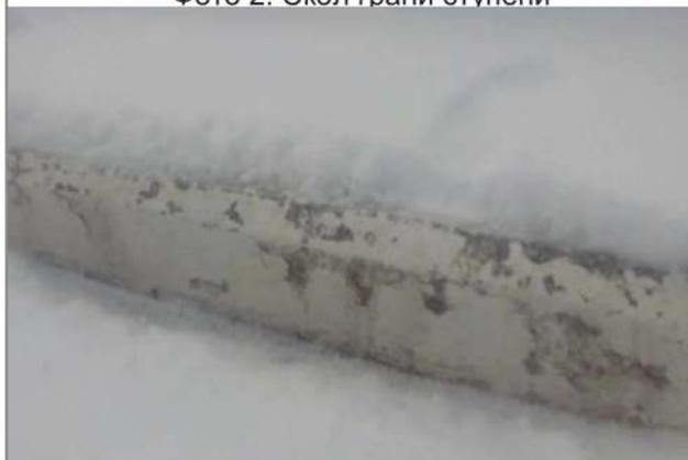
Фото 3. Разрушение отделочных покрытий ступеней
