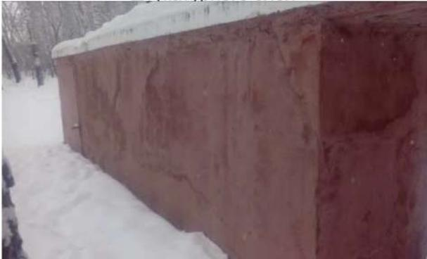
Фото 9. Увлажнение и морозно-влажностное разрушение отделочных покрытий
