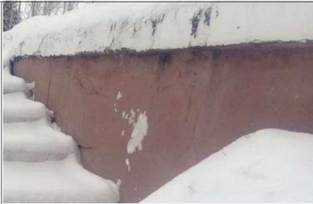
Фото 6. Увлажнение и морозно-влажностное разрушение отделочных покрытий
