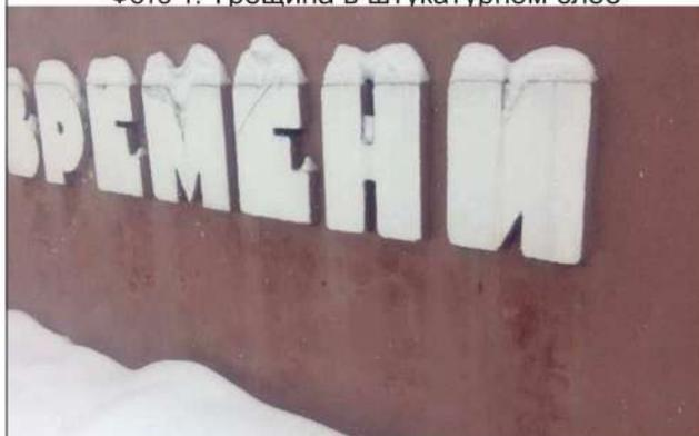
Фото 2. Увлажнение и морозно-влажностное разрушение отделочных покрытий
