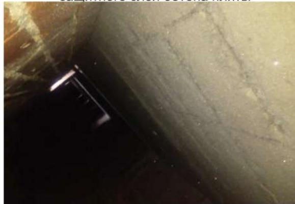
Фото 2. Увлажнение, поверхностное разрушение защитного слоя бетона плиты
