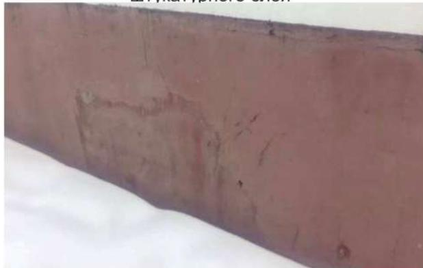
Фото 4. Увлажнение и морозно-влажностное разрушение отделочных покрытий
