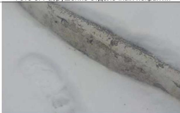
Фото 1. Разрушение отделочных покрытий ступеней
