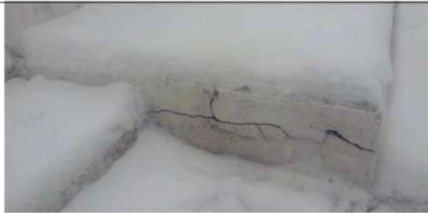
Фото 5. Трещины в облицовочном слое
