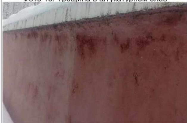
Фото 11. Увлажнение и морозно-влажностное разрушение отделочных покрытий
