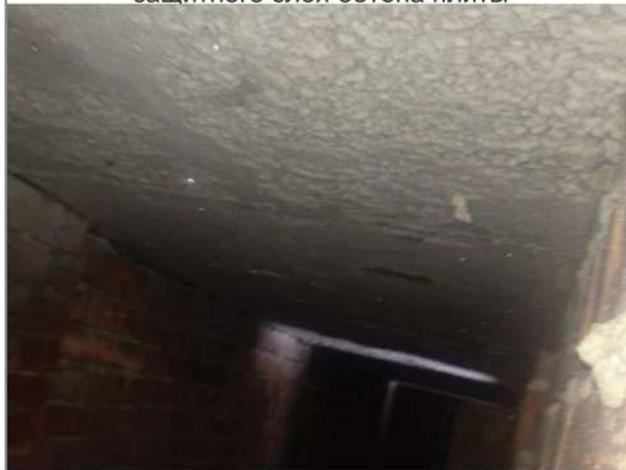
Фото 3. Увлажнение, поверхностное разрушение защитного слоя бетона плиты
