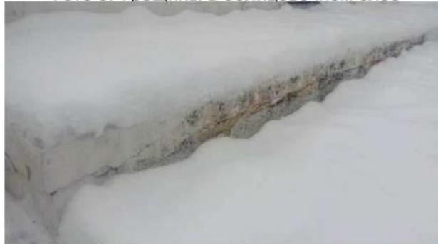
Фото 6. Трещины в облицовочном слое
