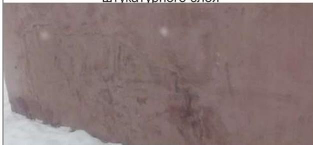
Фото 16. Увлажнение и морозно-влажностное разрушение отделочных покрытий
