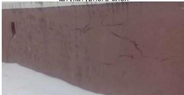
Фото 7. Увлажнение и морозно-влажностное разрушение отделочных покрытий
