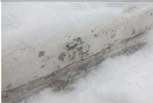
Фото 2. Трещина на участке сопряжения ступеней, разрушение отделочных покрытий (левый марш)
