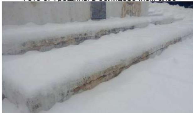
Фото 7. Трещины в облицовочном слое
