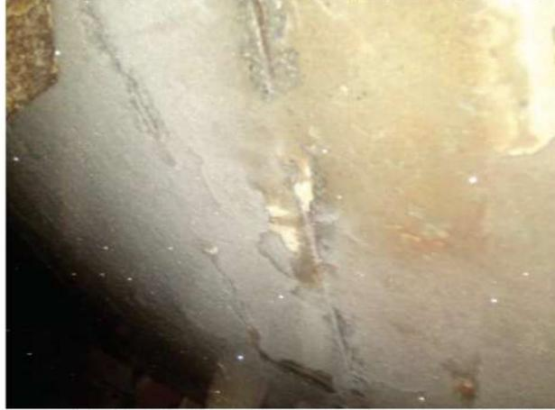
Фото 1. Увлажнение, поверхностное разрушение защитного слоя бетона плиты
