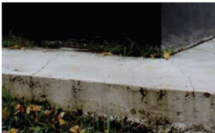
Фото 9. Трещины в поверхностном слое бетона постамента (фото 2016г)
