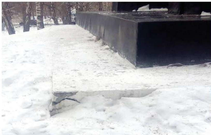
Фото 8. Повреждение поверхностного слоя бетона постамента
