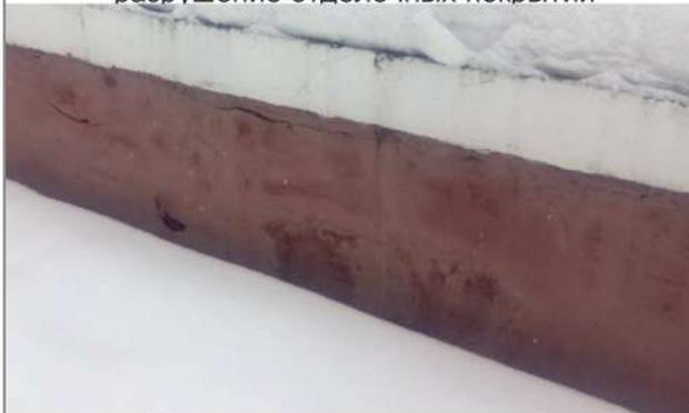
Фото 3. Увлажнение и морозно-влажностное разрушение отделочных покрытий
