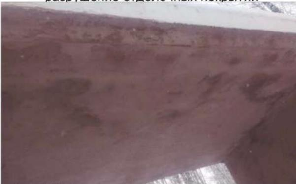
Фото 12. Увлажнение и морозно-влажностное разрушение отделочных покрытий
