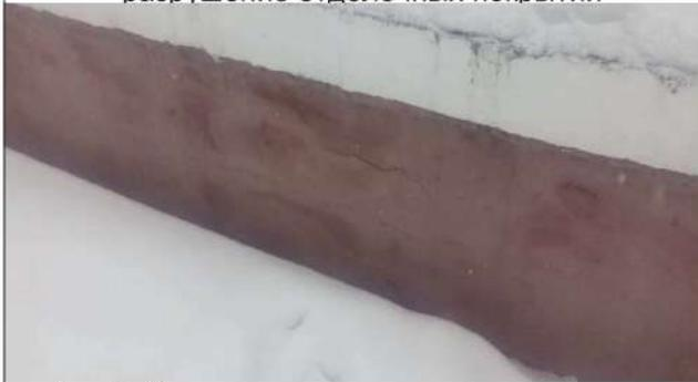
Фото 2. Увлажнение и морозно-влажностное разрушение отделочных покрытий
