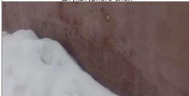
Фото 14. Увлажнение и морозно-влажностное разрушение отделочных покрытий
