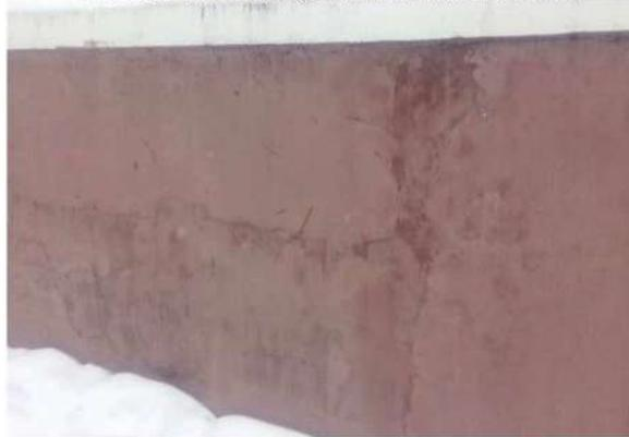
Фото 2. Увлажнение и морозно-влажностное разрушение отделочных покрытий
