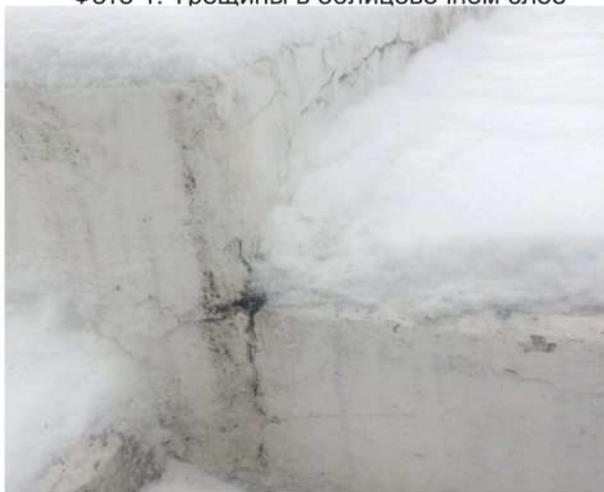
Фото 2. Трещины в облицовочном слое
