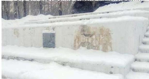
Фото 4. Разрушение отделочных покрытий
