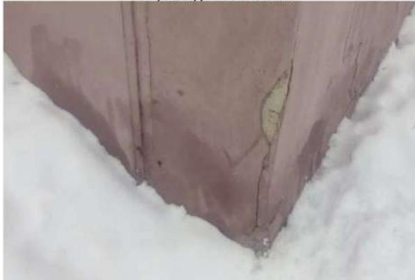
Фото 2. Трещина, отслоение и обрушение участка штукатурного слоя
