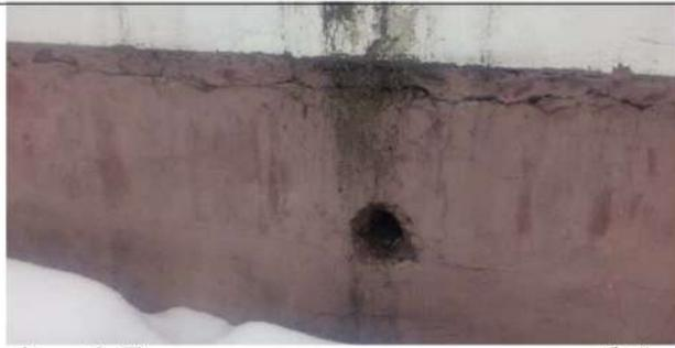
Фото 6. Трещины в штукатурном слое, пробой в кладке
