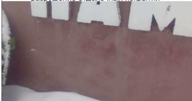
Фото 3. Увлажнение и морозно-влажностное разрушение отделочных покрытий слое
