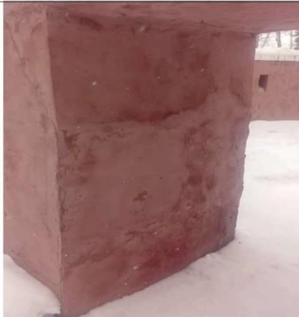
Фото 10. Увлажнение и морозно-влажностное разрушение отделочных покрытий
