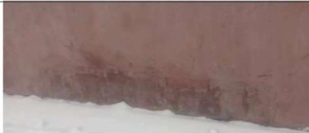
Фото 5. Увлажнение и морозно-влажностное разрушение отделочных покрытий
