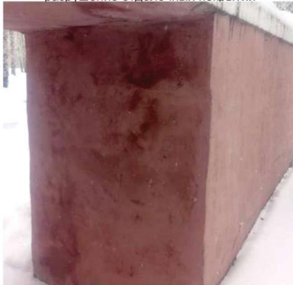
Фото 11. Увлажнение и морозно-влажностное разрушение отделочных покрытий
