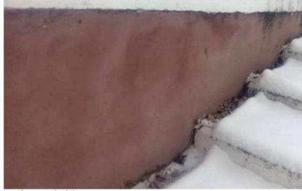
Фото 1. Увлажнение и морозно-влажностное разрушение отделочных покрытий
