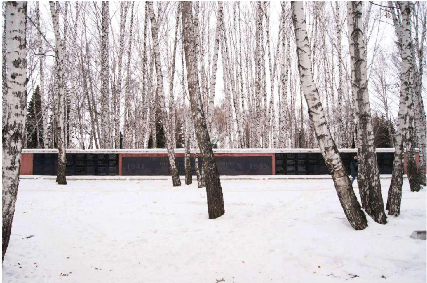
Фото 21 – Фрагмент ограждающей стены с внешней стороны
