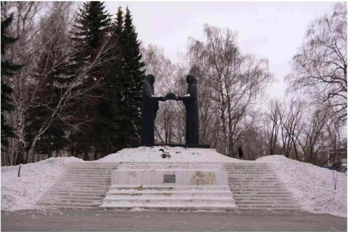
Фото 3 – Вид на монумент с нижней площадки с северной стороны
