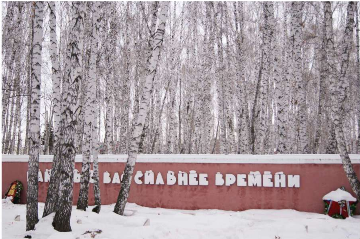
Фото 27 – Накладные буквы с внутренней стороны ограждающей стены. Вид с запада
