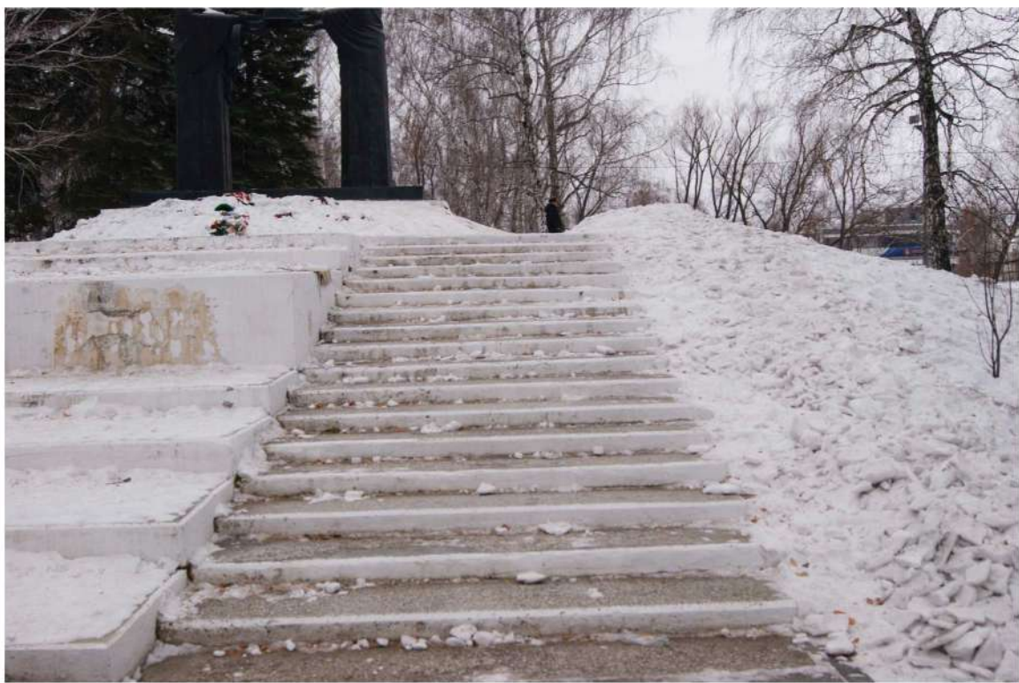
Фото 7 – Вид на правый лестничный марш с северной стороны
