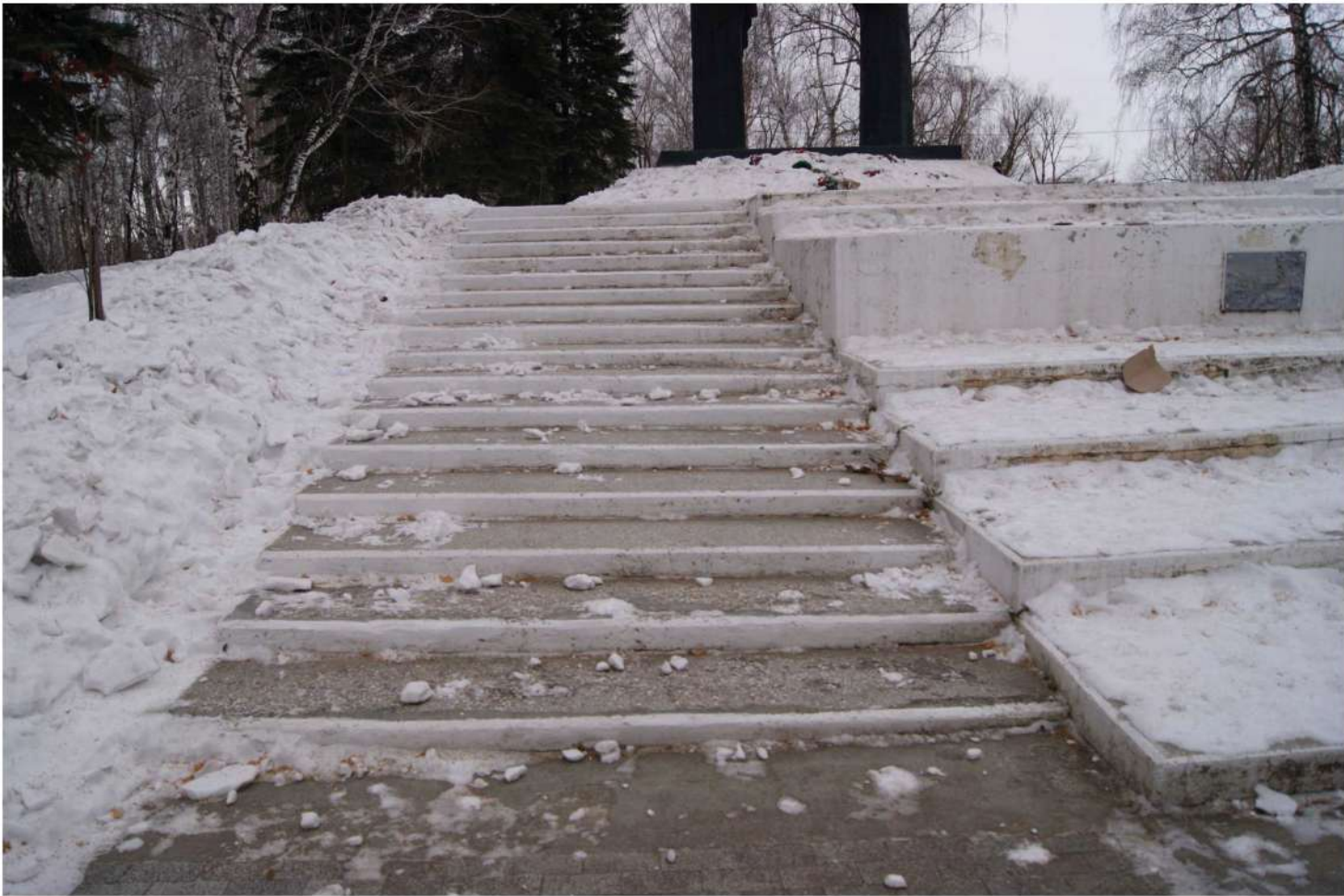
Фото 6 – Вид на левый лестничный марш с северной стороны
