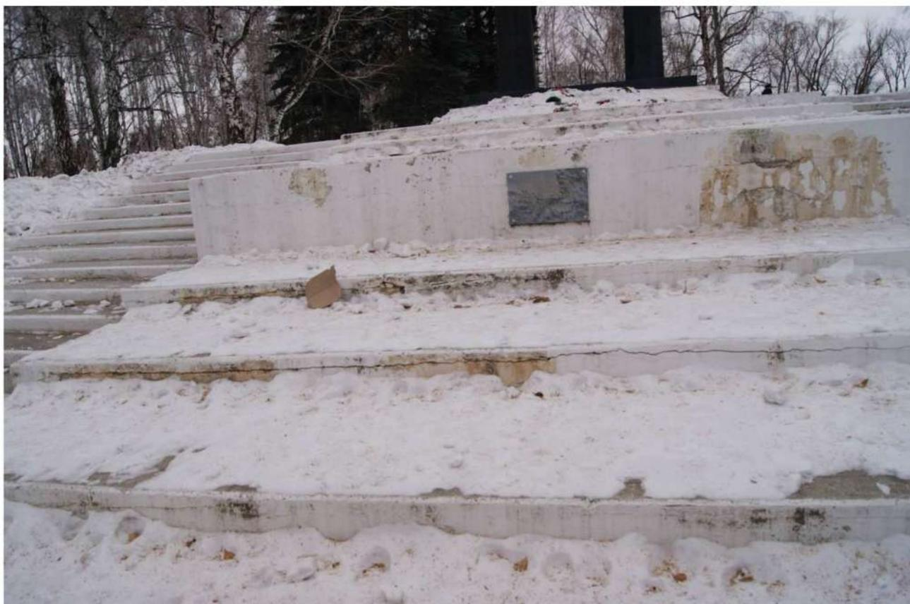
Фото 40. Вид на центральный лестничный марш с севера. Разрушение облицовочных слоев.
