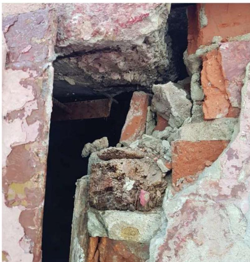
Фото 51. Разрушение опирания перемычки дверного проёма
