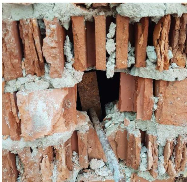
Фото 52. Сквозной пролом кирпичной кладки стены. Закладная деталь
